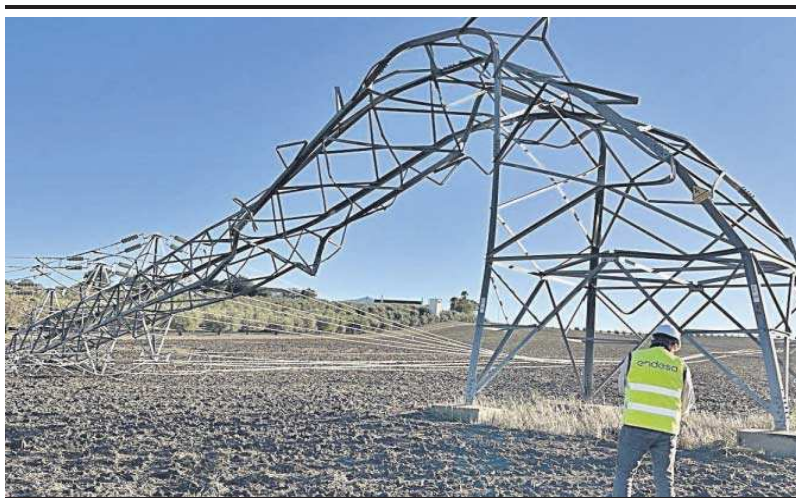
Torre eléctrica desplomada en Alcalá de Guadaíra, Sevilla, por la borrasca del día 22 de octubre.
