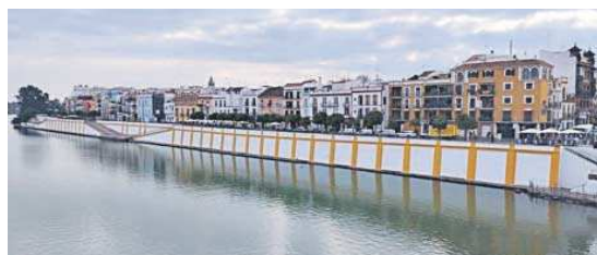
Zapata de la calle Betis tras las labores de limpieza. M.B.
