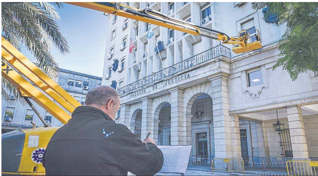
Juan López trabaja sobre un plano de la fachada principal mientras José Manuel García opera desde la grúa. Abajo, la zona vallada por seguridad.
