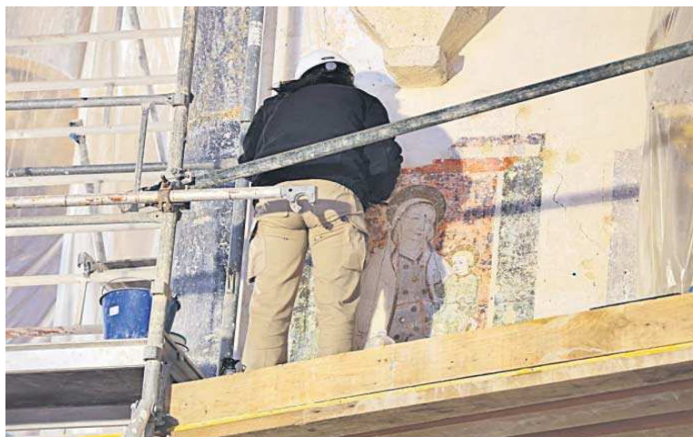
Trabajos de restauración de las pinturas murales encontradas en los paramentos.
