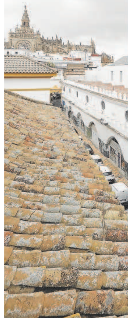
Una imagen exterior reciente de las obras que se acometen en las Atarazanas // RAÚL DOBLADO
