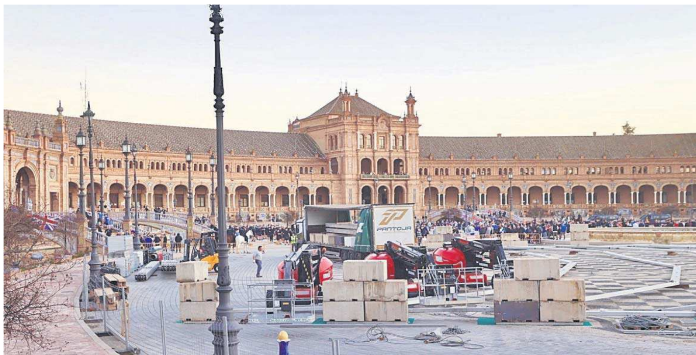
Los trabajos de montaje de la carpa en la Plaza de España.
