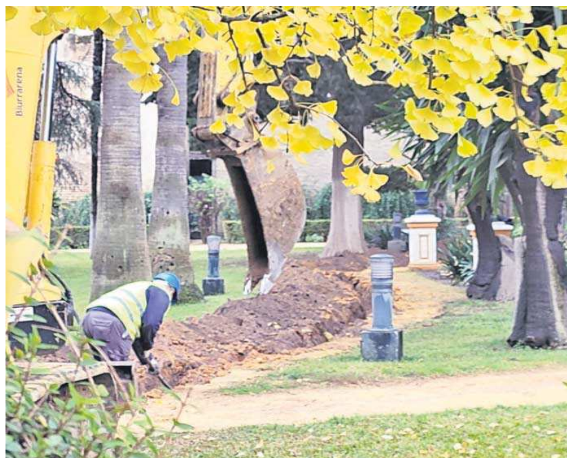
Un operario abriendo una zanja.
