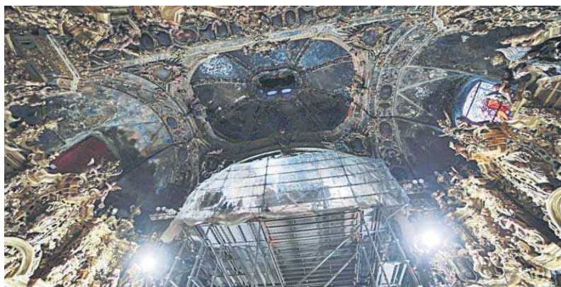
La zona del crucero, pendiente de intervenir, con el gran andamio en el que se trabaja actualmente.
