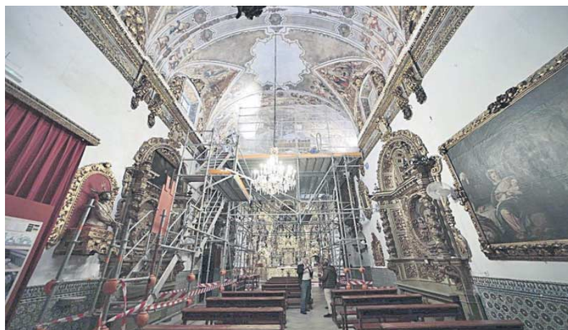
Vista general de la capillita con el andamio instalado.
