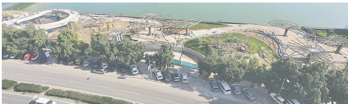
Una perspectiva casi cenital de las obras de construcción.
