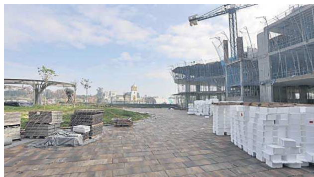
Vista a pie de obra.
