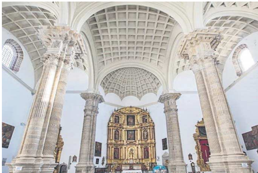
Las bóvedas renacentistas, a base de casetones, de la Parroquia de Nuestra Señora de Consolación.
