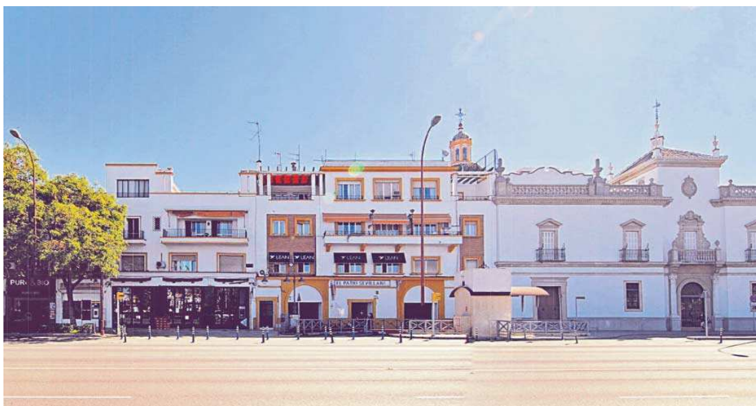
Estado actual de los edificios enclavados en los números 10 y 11 del Paseo de Colón.
