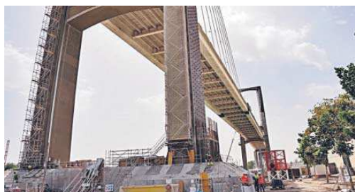
El puente del Centenario en obras.
