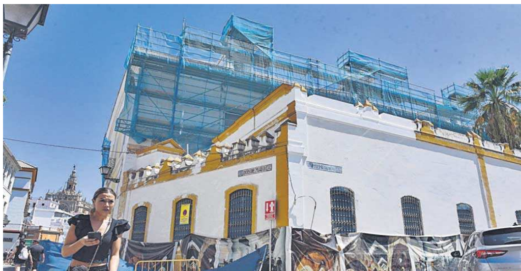
Las obras en las Reales Atarazanas.
