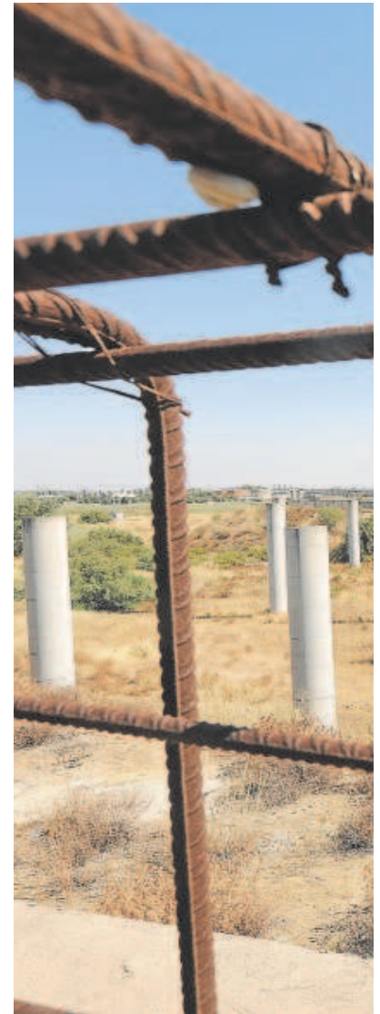
La zona donde se construirá el puente sobre el
