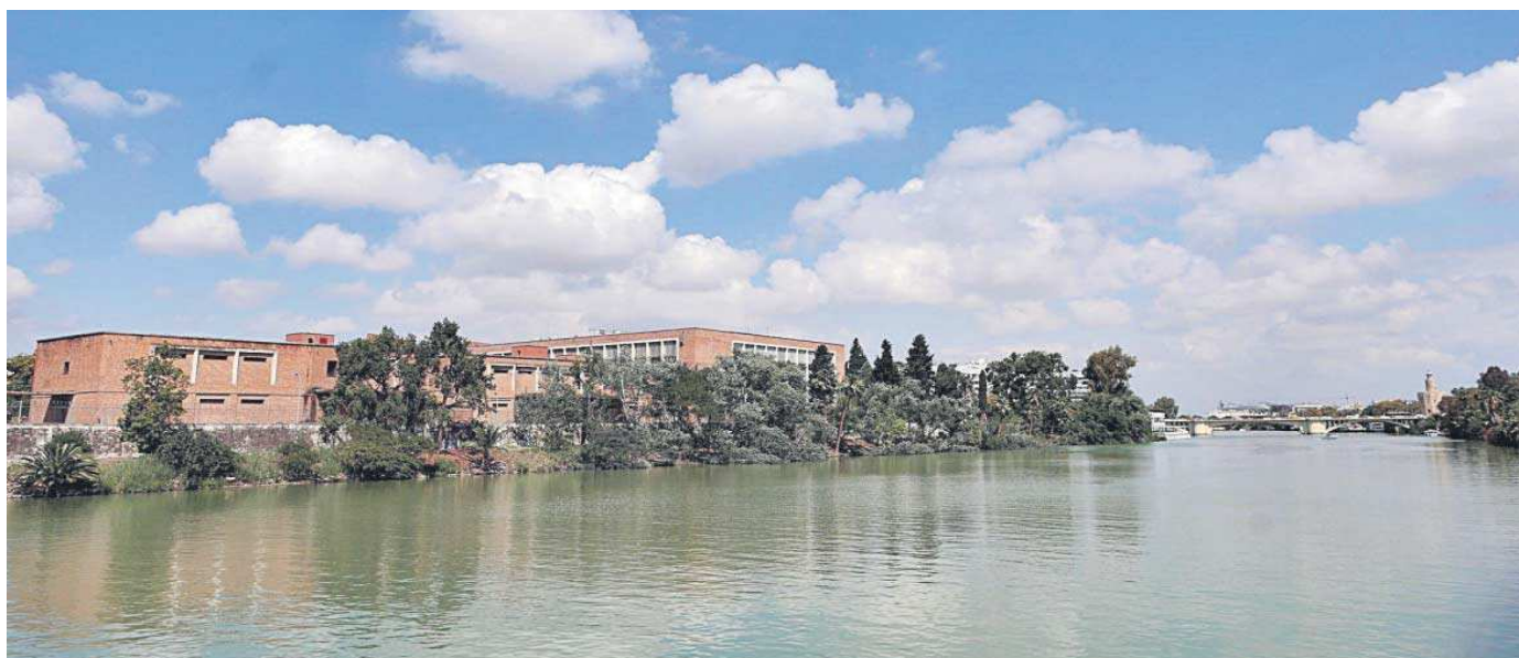
Zona en la que se construirá la nueva pasarela peatonal para conectar el paseo de las Delicias y Altadis.
