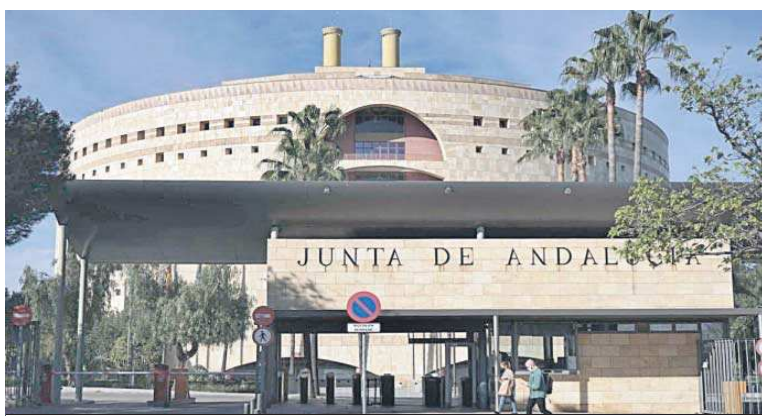
Puerta de acceso a la Consejería de Economía en el edificio Torre Triana.
