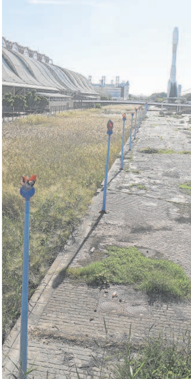
Imagen del Canal de la Expo en la isla de la Cartuja // J. M. SERRANO
