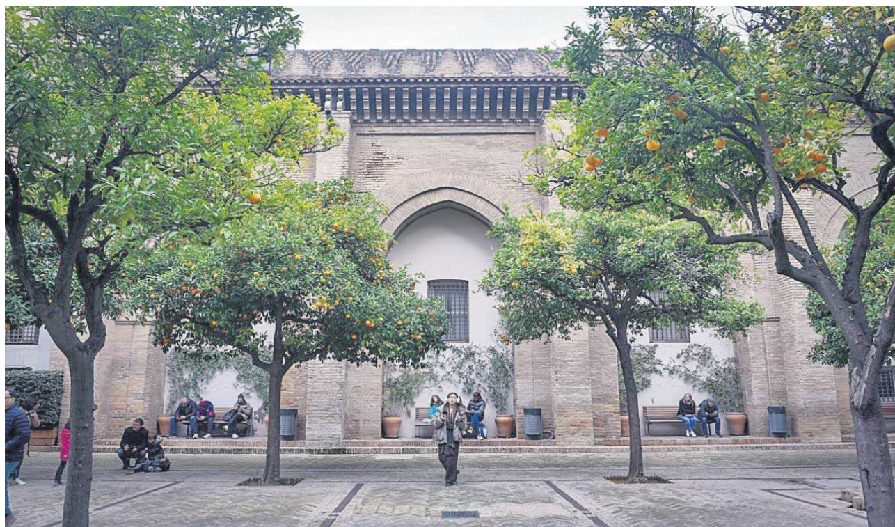
La fachada norte del Patio de los Naranjos sobre la que se actuará este año.
