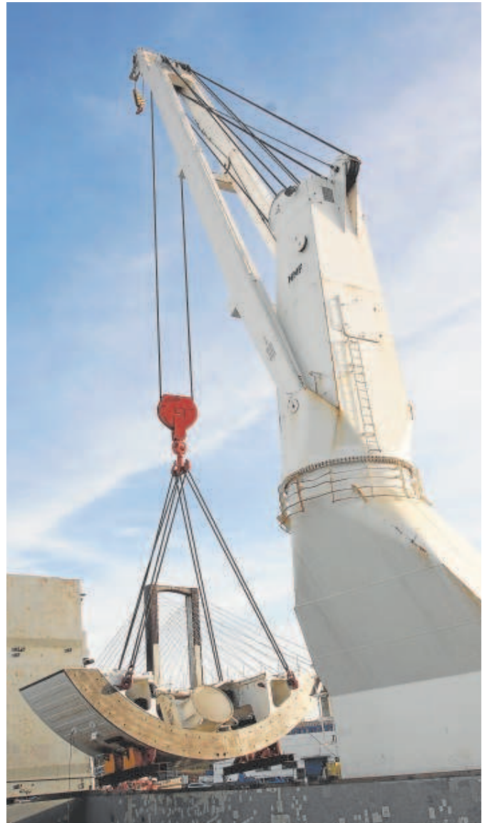
La tuneladora que se compró para hacer la obra // JUAN CARLOS RANGEL
