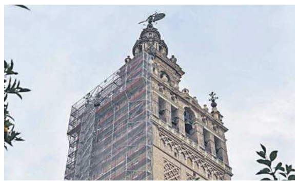
Las obras en la Giralda.
