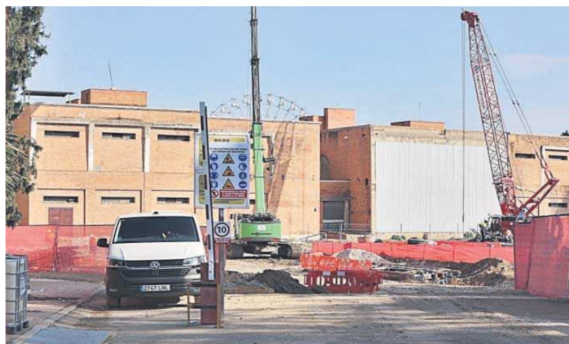
Estado actual de las obras en el interior de la antigua fábrica de tabacos.
