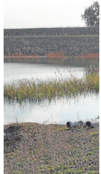
BLOQUE I VALORACIÓN DE LAS OBRAS EJECUTADAS
