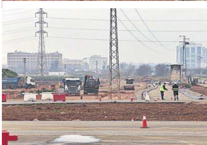
Obras del ramal técnico en el Higuierón. Las dos imágenes muestran las obras del ramal técnico del Metro, justo en el tramo anterior al de Pino Montano.
