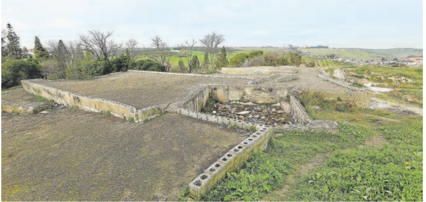
Estado en el que se encuentra el cerro del Carambolo que ha pasado ya a manos de la Junta de Andalucía // J.M. SERRANO
