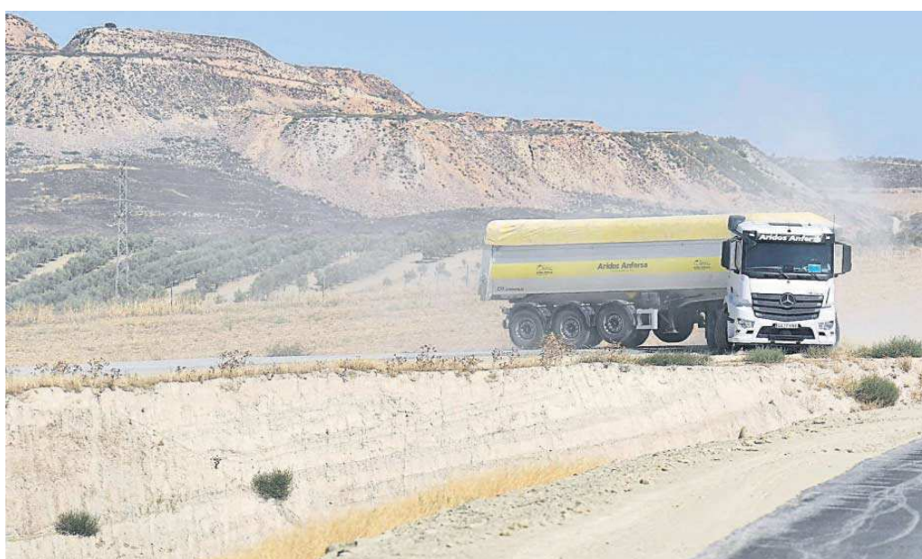
Un camión de la empresa bastetana, durante las obras de la Segunda Circunvalación de Granada.
