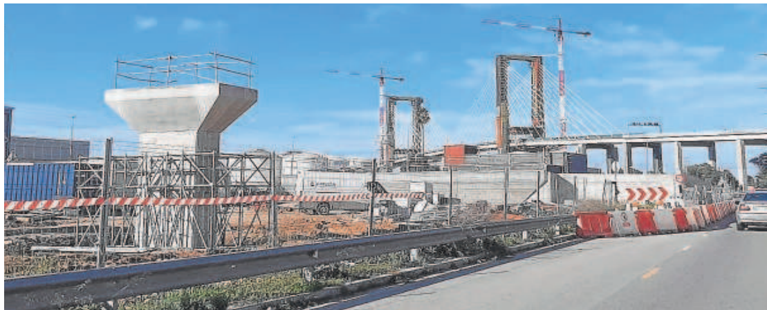
Estado actual que presentan las obras del Centenario vistas desde las inmediaciones del centro comercial Lagoh //M.L.
