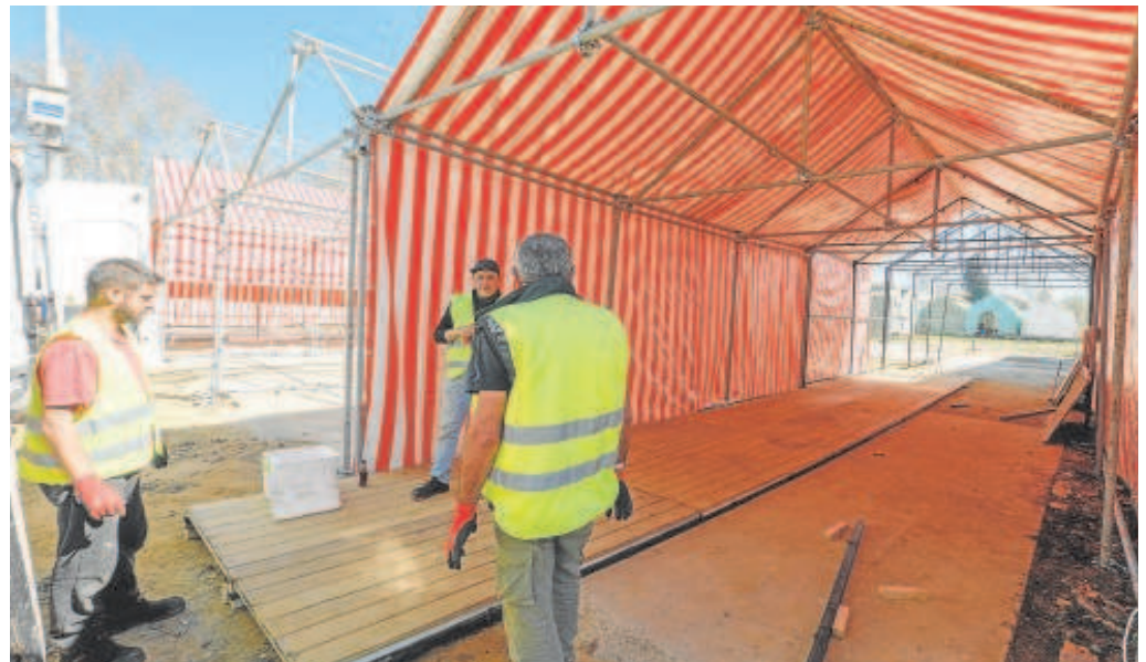
Sobre estas líneas trabajos de montaje de la Feria de Sevilla // RAÚL DOBLADO
