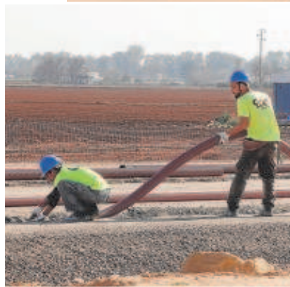
Sobre estas líneas, dos imágenes de las obras del ramal técnico del metro de Sevilla que ya están avanzadas // FOTOS: MANUEL GÓMEZ
