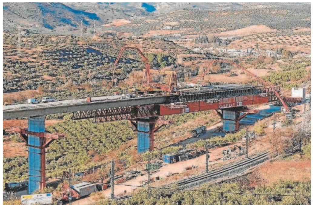
Obras estatales de la variante de Loja // IDEAL
