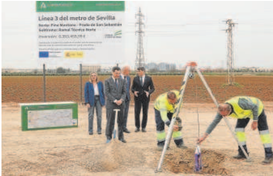
Primera piedra del ramal norte de la línea 3 del metro de Sevilla // J. M. SERRANO
