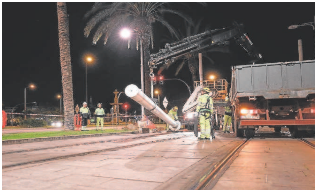
Una imagen de la retirada de las catenarias // ABC
