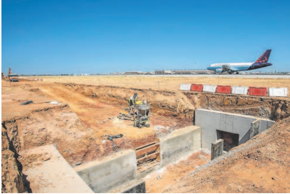
Varios operarios trabajando en los alrededores del aeropuerto de Sevilla // VANESSA GÓMEZ
