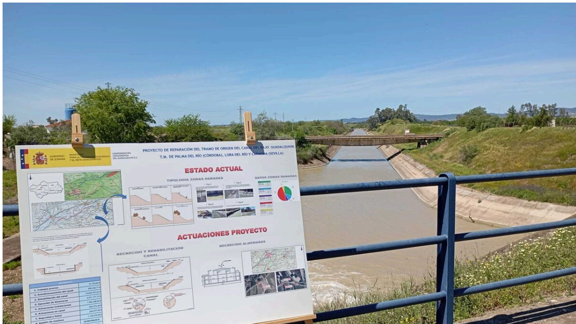
Tramo origen del Canal del Bajo Guadalquivir / CHG
