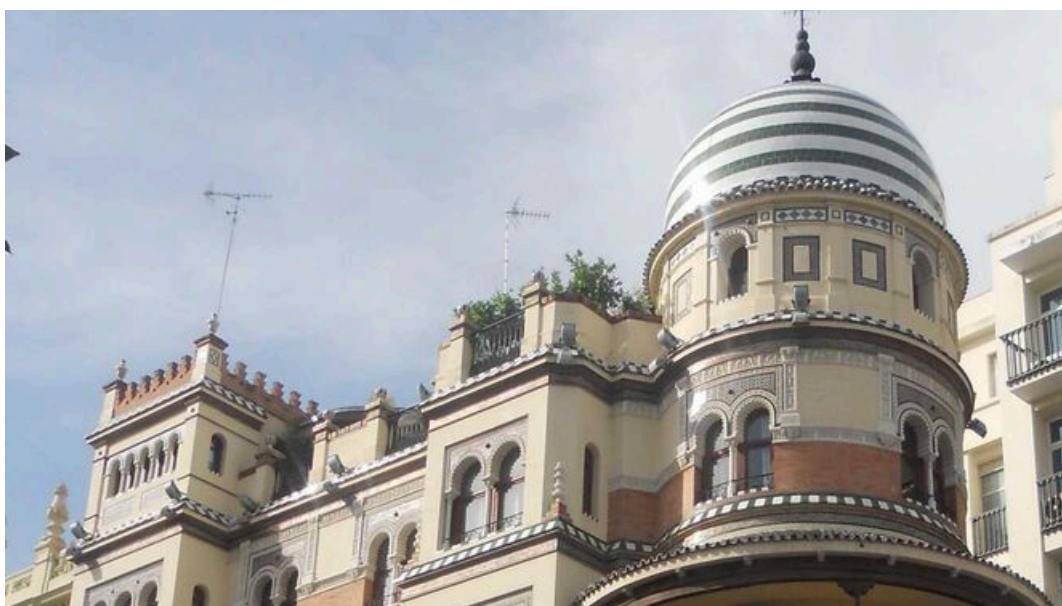
Fachada del edificio de La Adriática / Andalucía.org
