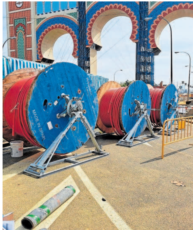
El nuevo cable que se instala en el real de la Feria // ABC
