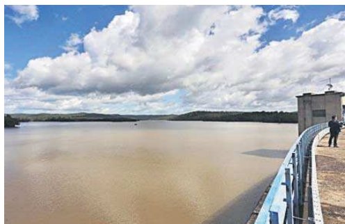
Vista del vaso de la presa del Gergal rebotante de agua.
