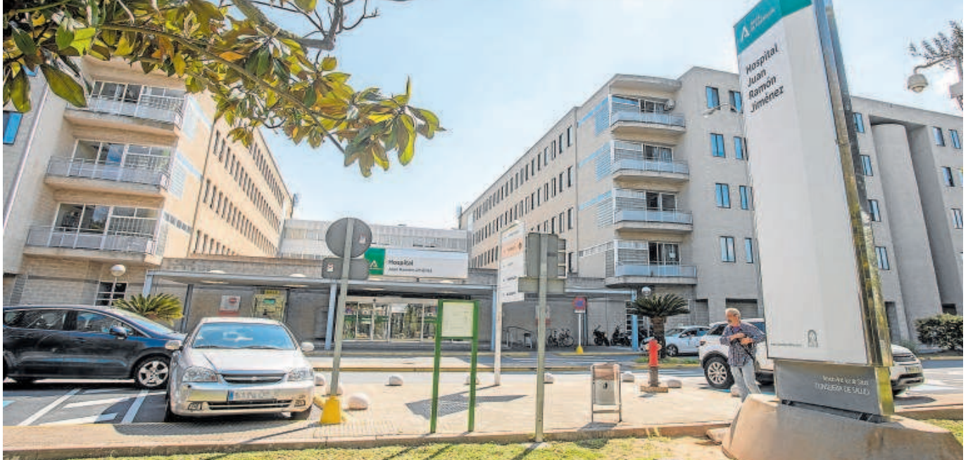
Exterior del hospital Juan Ramón Jiménez de Huelva // ALBERTO DÍAZ
