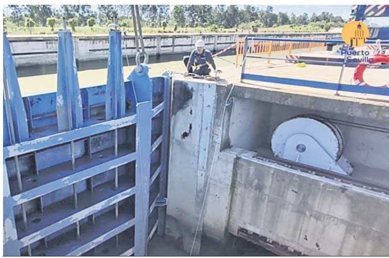
Un operario trabajando en la esclusa del Puerto de Sevilla.
