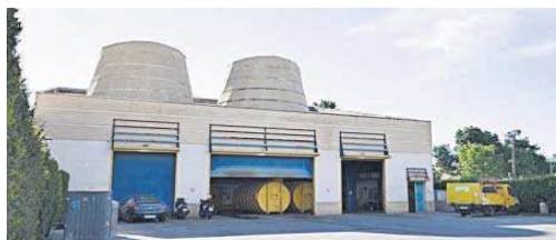
Una de las tres centrales de Pino Montano de recogida neumática.
