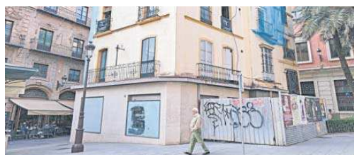
Vista del inmueble desde la calle Entrecárceles.
