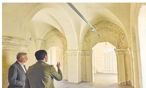
Primo Jurado y Gómez Villa en la Sala Abovedada que se ha recuperado.
