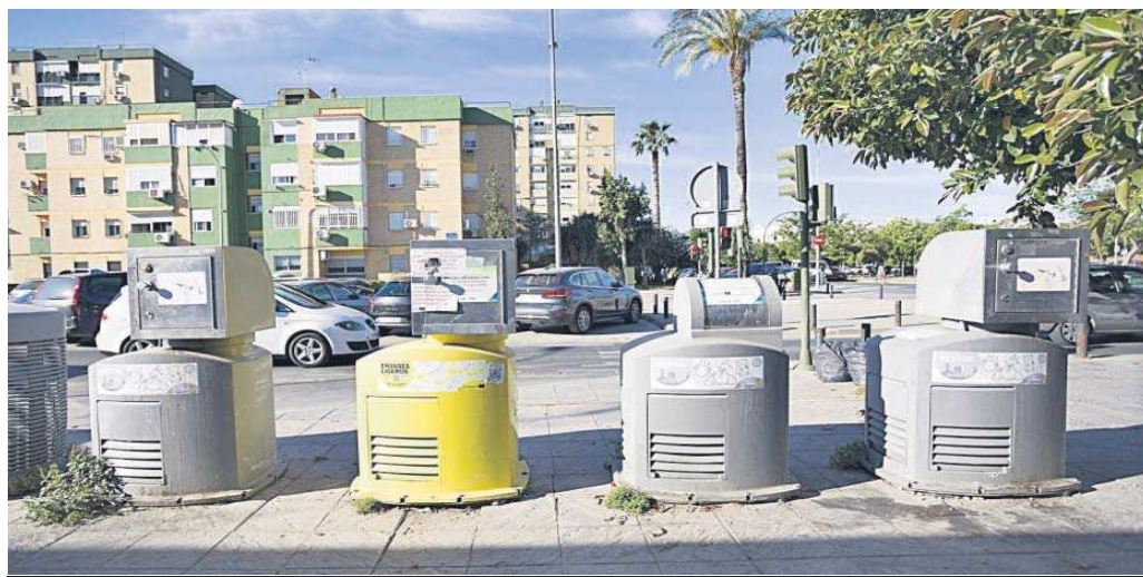
Contenedores de recogida neumática de basura en Pino Montano.
