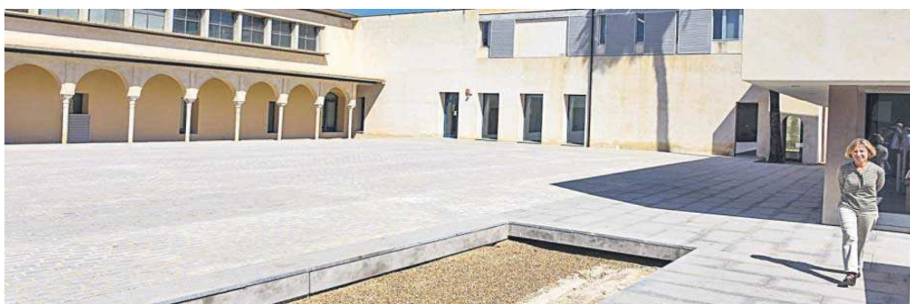
El Claustro de Legos con su nueva plataforma. A la izquierda, la arquería restaurada en 1991.
