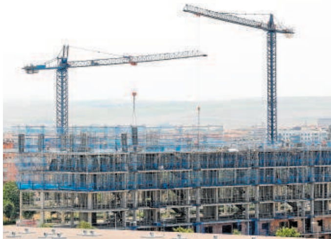
Bloques de viviendas en construcción en Córdoba // VALERIO MERINO
