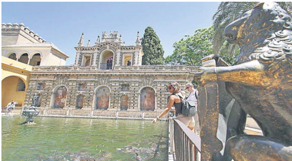
Las pinturas objeto de la actuación de emergencia con el estanque en primer plano.
