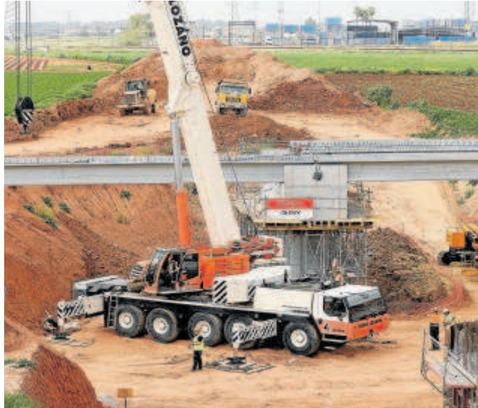
Obras de la línea 3 del metro de Sevilla // R. DOBLADO
