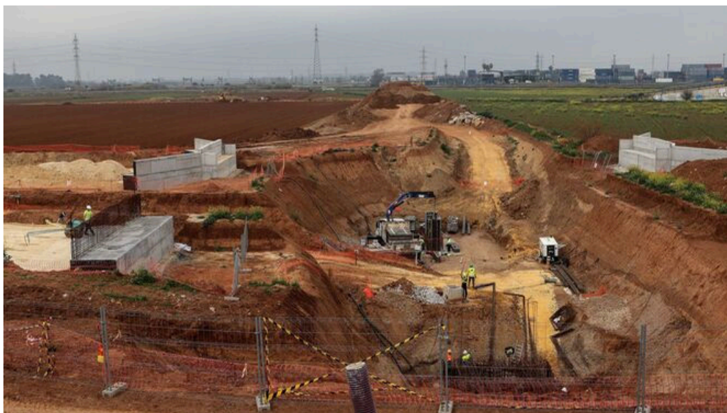
Obras del ramal técnico del tramo Norte de la línea 3 en el Higuero. / Consejería de Fomento
