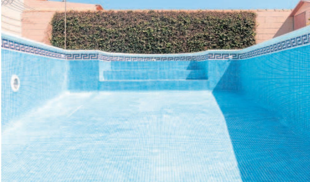
Imagen de archivo de una piscina pendiente de ser llenada de agua // ABC
