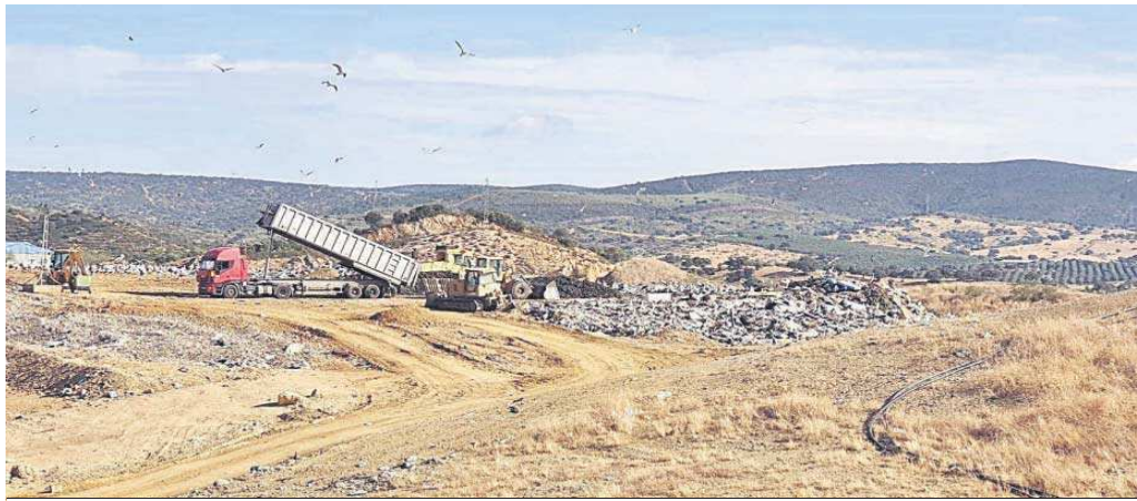
Vertedero controlado de la Mancomunidad de La Vega.
