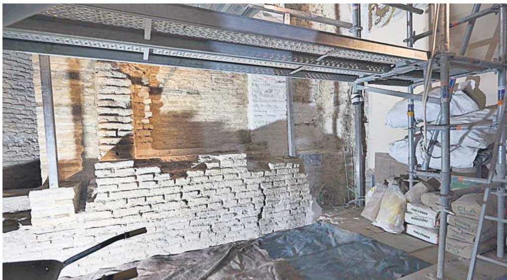
El muro de cierre de la sinagoga que ha quedado a la vista tras desmontarse el retablo mayor.
