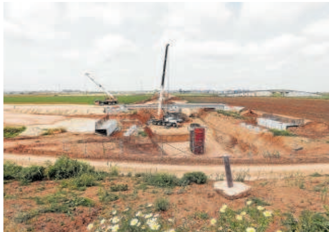
Los trabajos de construcción de la línea 3 del metro // R. DOBLADO
