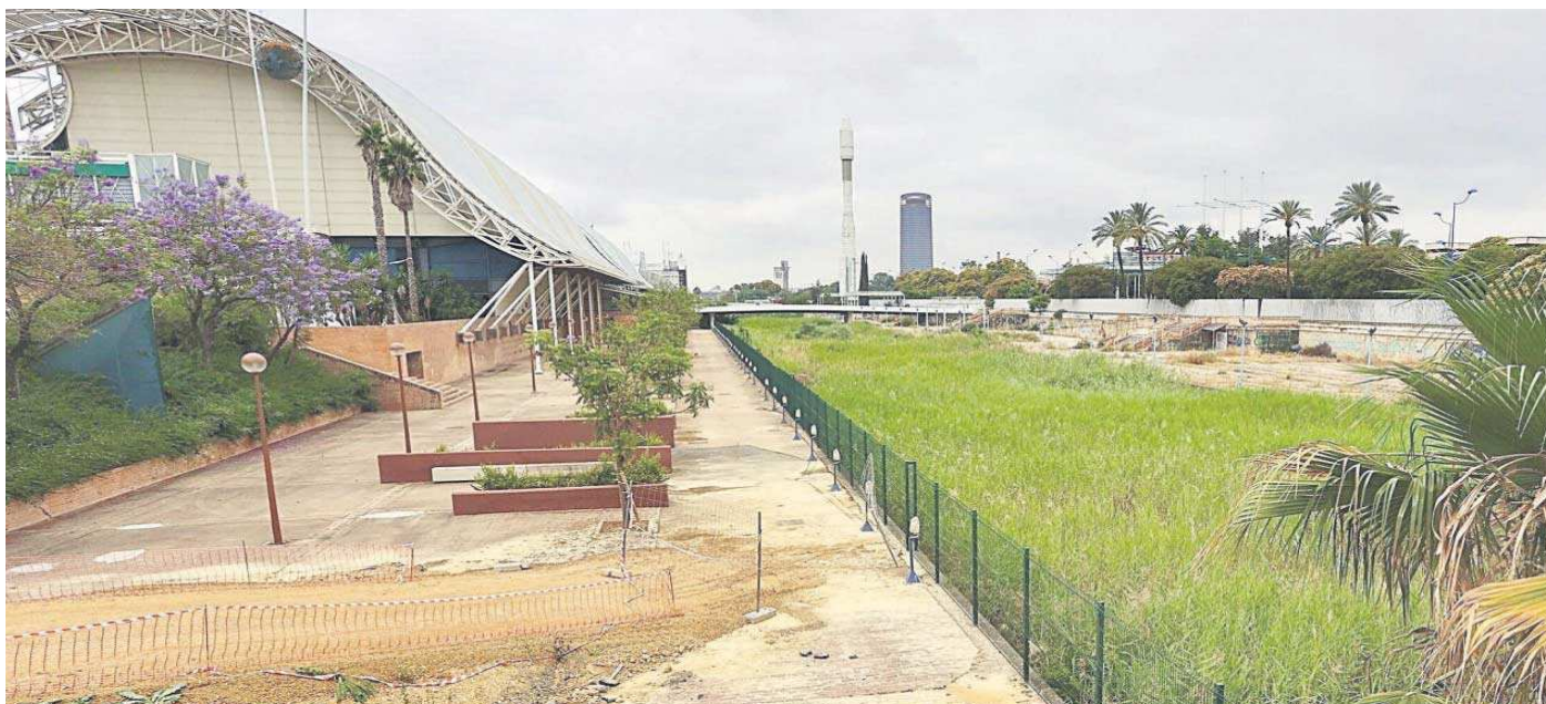
Estado actual del Canal de los Descubrimientos, abandonado y repleto de hierba silvestre de gran altura.
