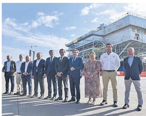
La familia Camino de Tecade y las autoridades delante de la subestación.
