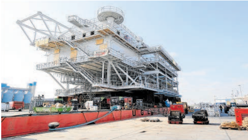
Los operarios ultimán detalles en la segunda subestación eléctrica hecha en el Puerto de Sevilla // J. M. SERRANO
