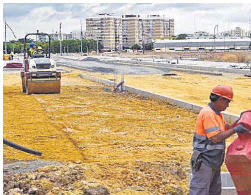
Varios operarios trabajan en la reurbanización de la parcela.
