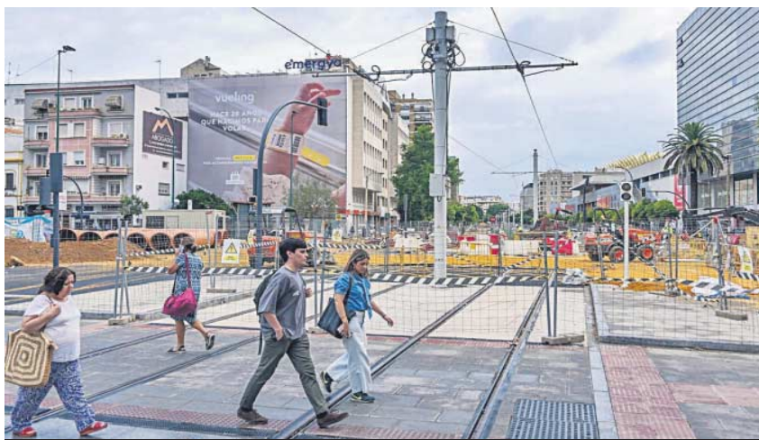
Vista del tramo cortado por obras de Emasesa en Eduardo Dato y Luis de Morales.
