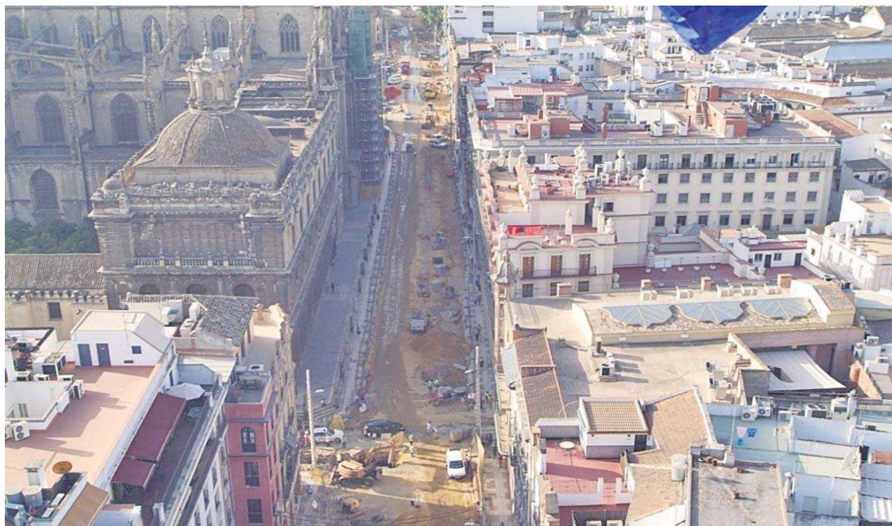
Obras del tranvía en la Avenida junto a la Catedral.
