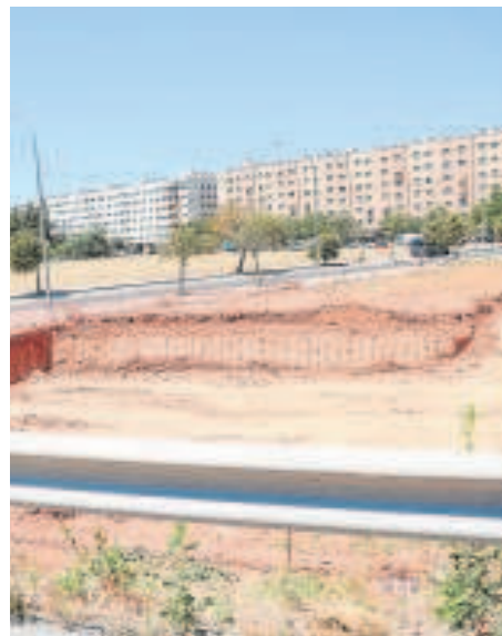
Obras del metro en Pino Montano // EP
