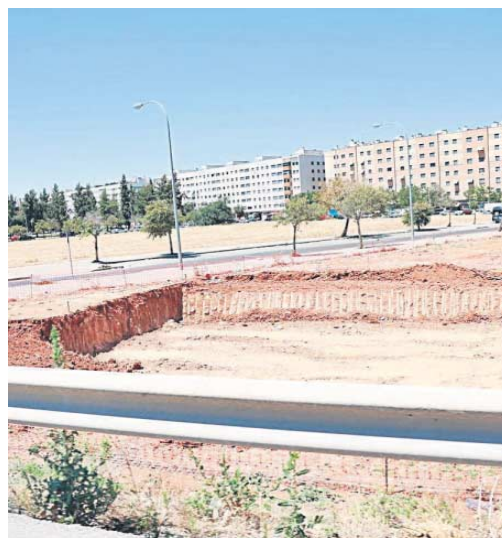
Obras del Metro en la calle Estrella Deneb de Pino Montano.
