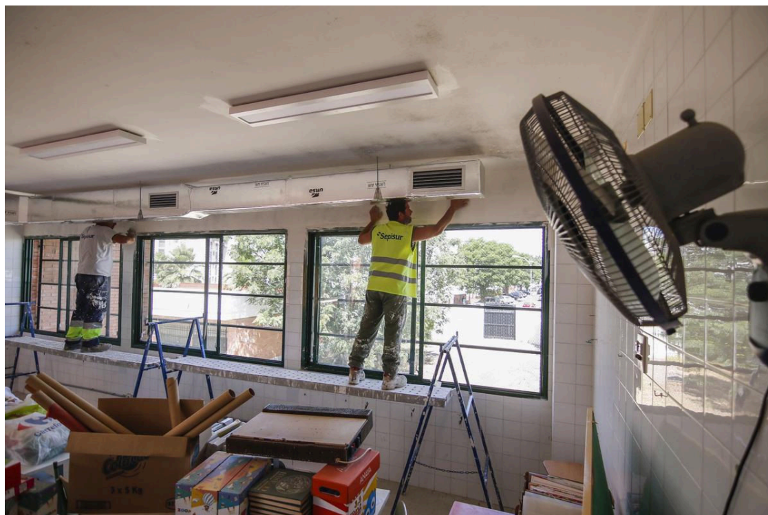
Obras aire acondicionado en el CEIP Albolafia (Córdoba) / A. J. González
