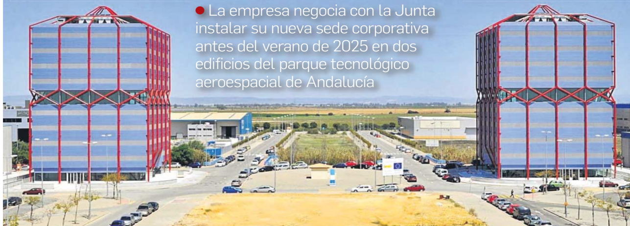
Abengoa elige una de las dos torres (a la derecha de la imagen) del Centro de Ingeniería e Innovación Aeroespacial para instalar su nueva sede.
