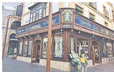
Exterior actual de la histórica confitería sevillana.
