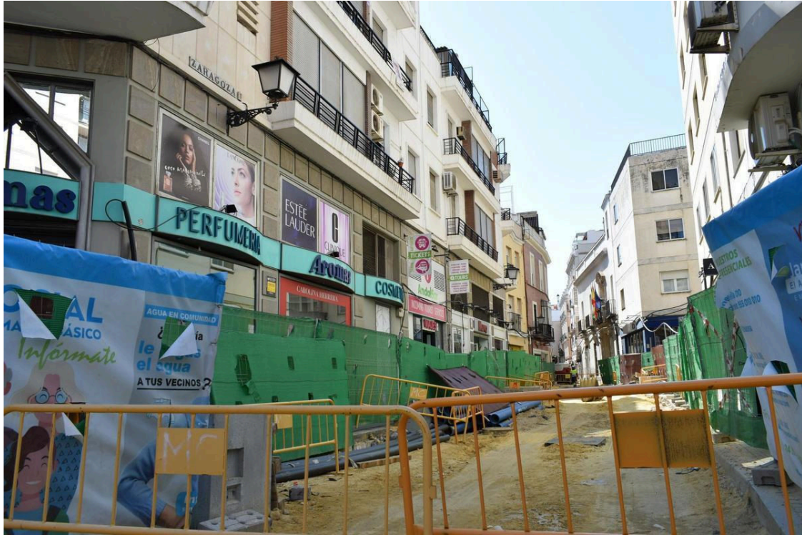
La calle Zaragoza es una de las que están en obras, cortando toda la vía
