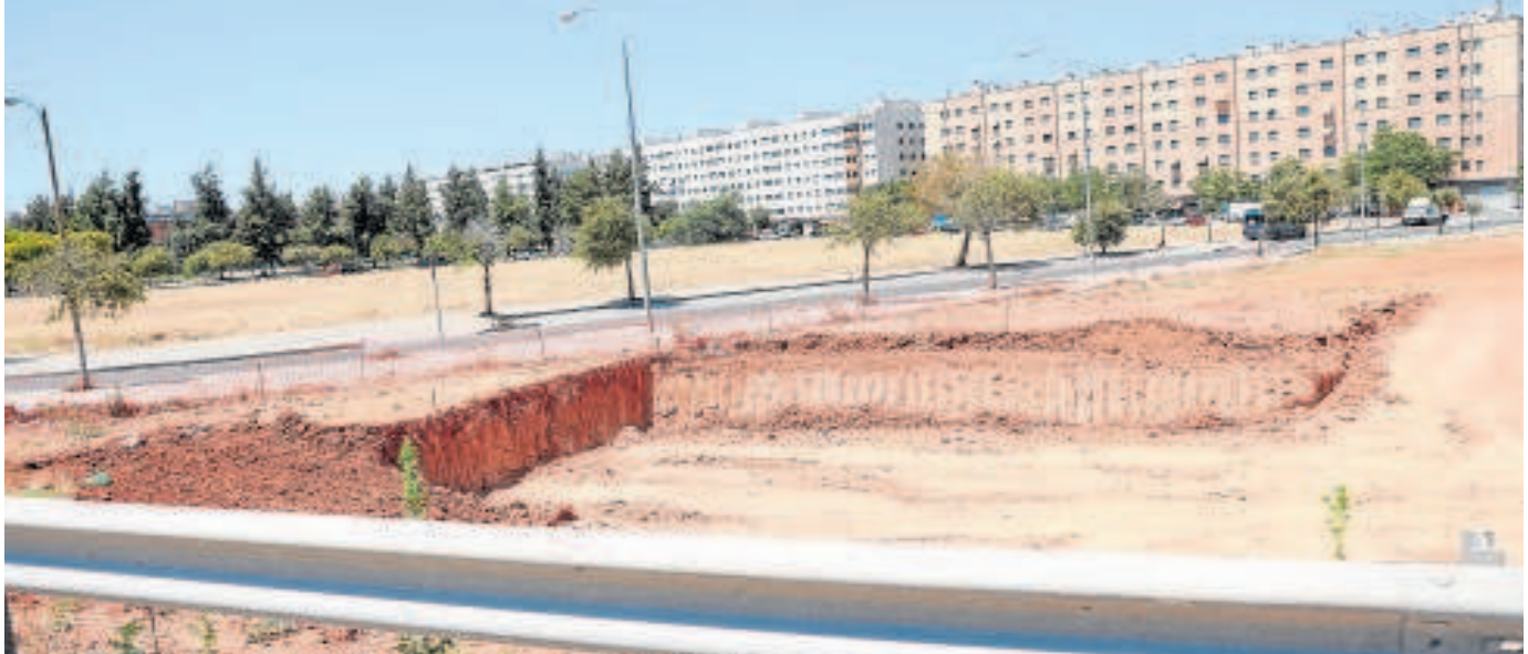
Obras de la línea 3 del metro de Sevilla junto a la calle Estrella Deneb, en Pino Montano // EP/ROCÍO RUIZ
