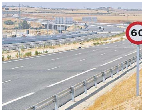
LA SE-40 en el tramo que confluye con la A-92. JUAN CARLOS VÁZQUEZ
