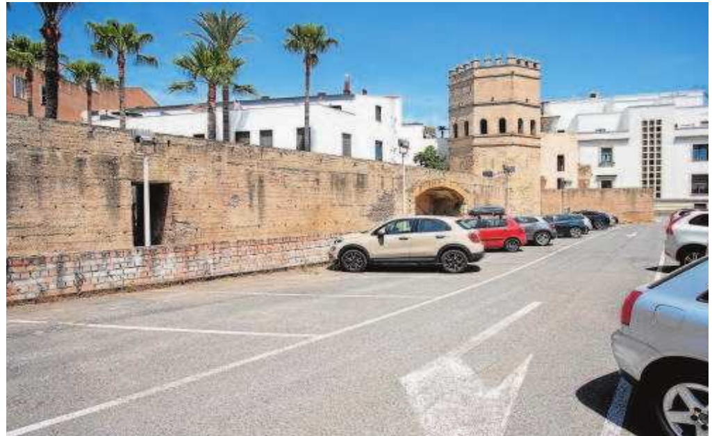
Parking en el entorno de la Torre de la Plata, cuya concesión termina en diciembre de este año // ABC
