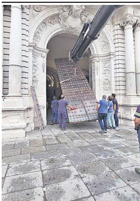
Colocación de la puerta de 2.500 kilos en el Rectorado de la US.
