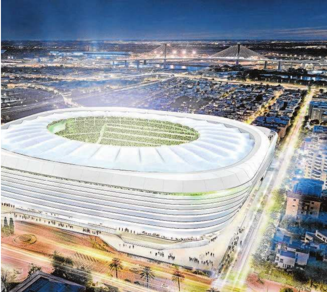
Así será el nuevo Estadio Benito Villamarín cuando finalicen las obras de la grada de Preferencia.
