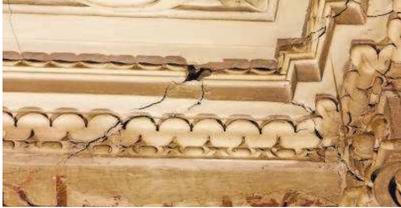
En el extremo izquierdo, se puede apreciar la malla de seguridad ante desprendimientos en la cúpula de la iglesia. A la derecha, detalle de las grietas en las yeserías y, abajo, humedades en la fachada
