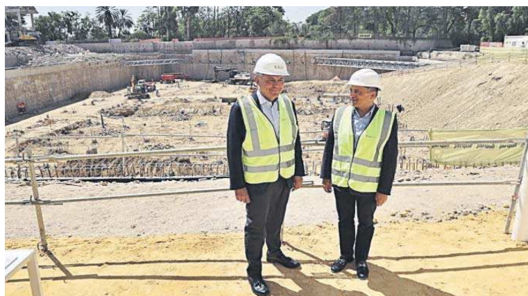
José Luis Sanz y José María Ferrer delante de las obras que se acometen para el hotel de gran lujo.
